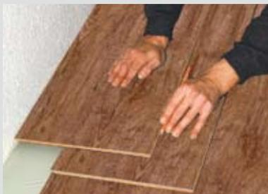
**6** Einpassen der letzten Dielenreihe: Legen Sie exakt auf die zuletzt verlegte Dielenreihe die nachzusägende Diele. Dann zeichnen Sie mit Hilfe einer weiteren Diele den Längsschnitt an.
