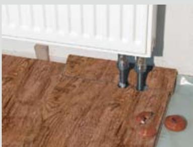
**4** Bei Heizungsrohrdurchbrüchen die Diele am Stoß ausklinken und mit Heizkörperrosetten abdecken.
