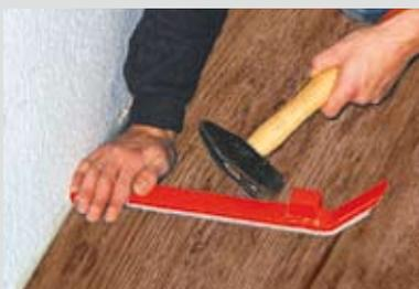
**7** Die letzte Dielenreihe wird mit dem Zugeisen längsseitig und mit dem Schlagholz stirnseitig zusammengetrieben.
