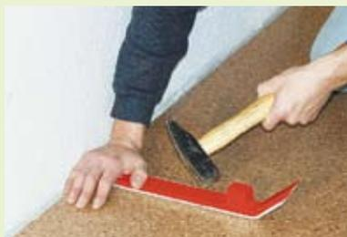
**7** Die letzte Dielenreihe wird mit dem Zugeisen längsseitig und mit dem Schlagholz stirnseitig zusammengetrieben.
