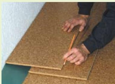
**6** Einpassen der letzten Dielenreihe: Legen Sie exakt auf die zuletzt verlegte Dielenreihe die nachzusägende Diele. Dann zeichnen Sie mit Hilfe einer weiteren Dielen den Längsschnitt an.
