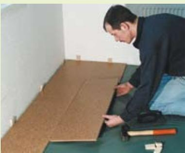
**3** Nachdem die erste Reihe mittels einer Setzlatte exakt ausgerichtet wurde, beginnen Sie mit dem Reststück der letzten Diele der ersten Reihe die Verlegung der zweiten Reihe. Die Stirnstöße (Querfugen) der Dielen von Reihe zu Reihe müssen jedoch mind. um 30 cm versetzt sein.
